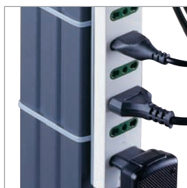
Verticale a montante, tramite fascette 0B30090.
